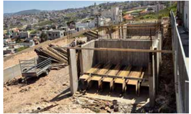
أعمال البناء في المدفن الجديد
