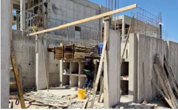
أعمال البناء في المدفن الجديد
