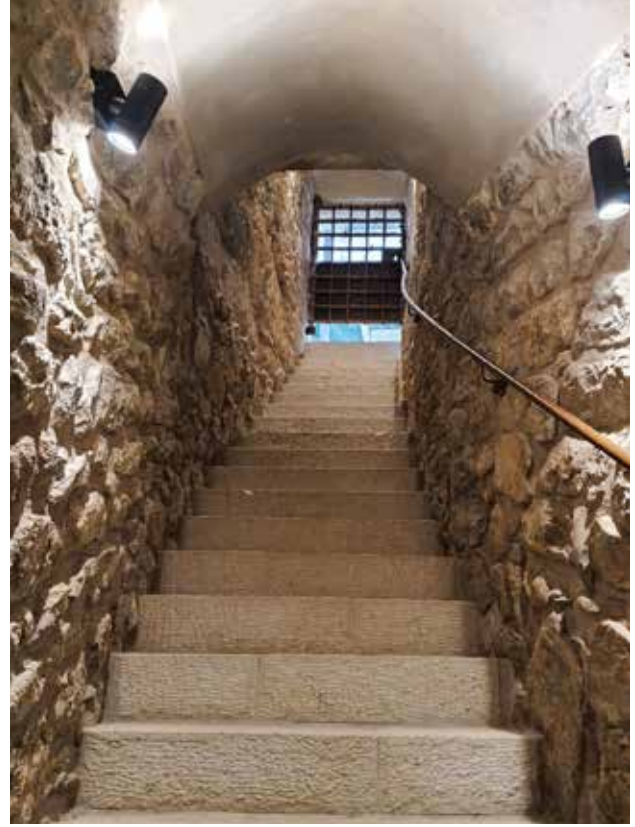
ترميم الدرج من المغارة الى منطقة الحفريات خلف الكنيسة
