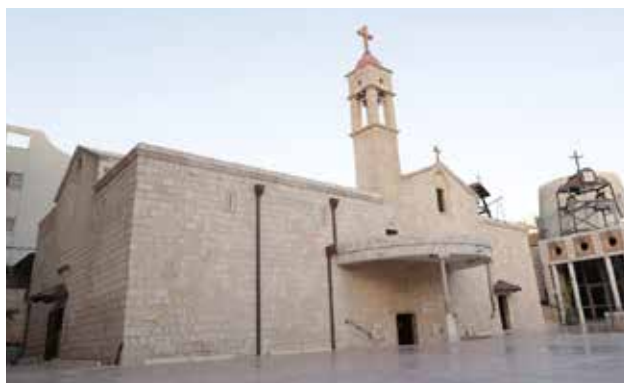
الكنيسة بعد الترميم
